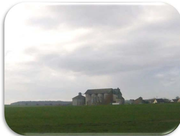
Site industriel - Silo
